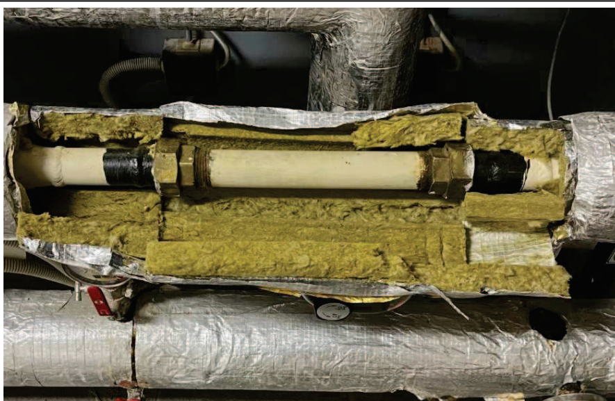
Obrázek 3: stávající mezikus primárního okruhu – DN25
