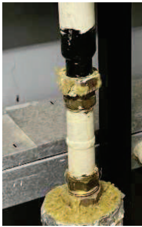
Obrázek 5: stávající mezikus okruhu VZT – DN20
