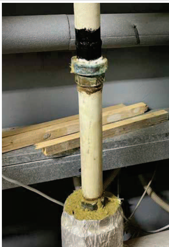
Obrázek 4: stávající mezikus okruhu ÚT – DN25
