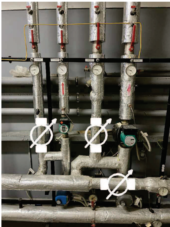
Obrázek 2: místa instalace měřičů tepla
